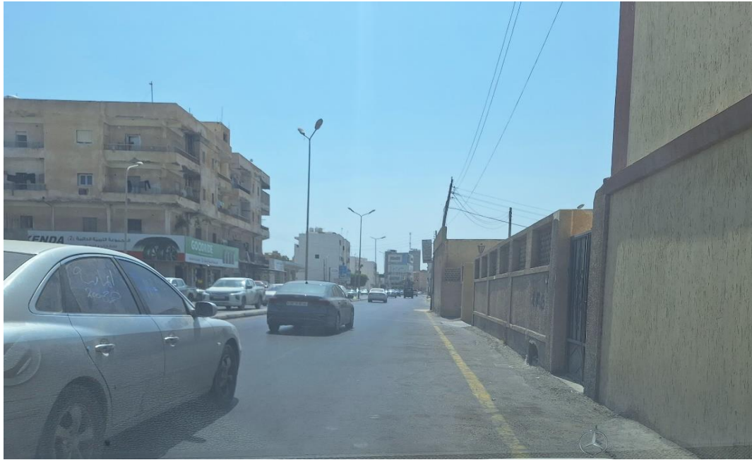
الشكل (11): صورة للبناء على حساب ارتداد الطريق (الرصيف) شارع بنغازي.
